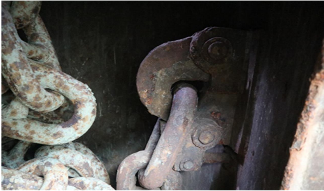
锚链舱内锈蚀的锚链和弃链器
