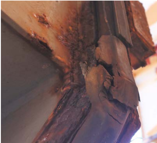
密封胶条破损
