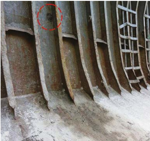
舱壁破损进水
